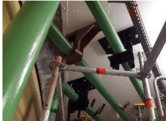
Pose de renforts sur les tuyauteries ASG
