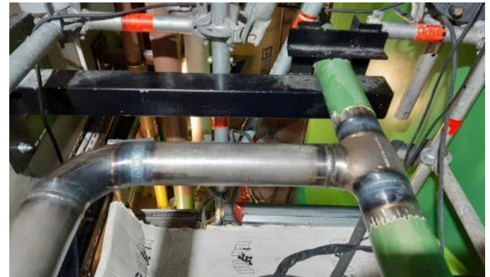
Soudage d'un té de raccordement sur ASG
