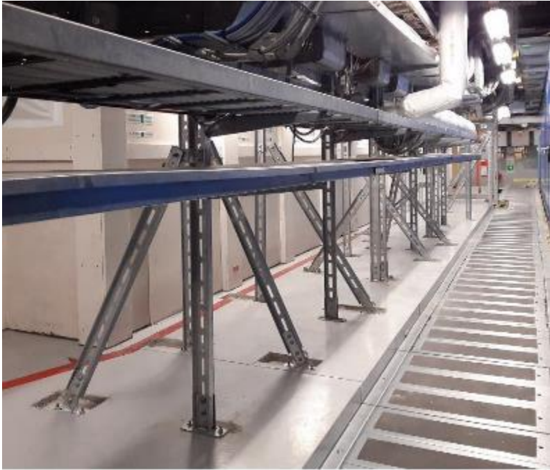
Pose de renforts sur les tuyauteries ASG
