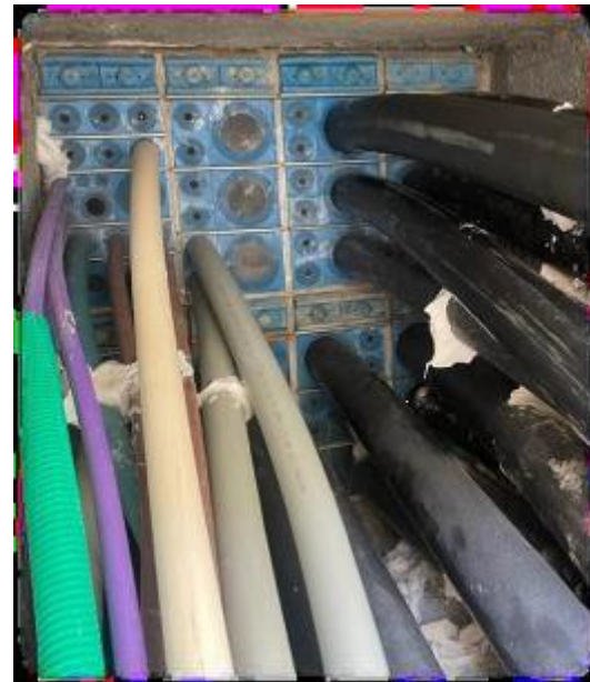
Passage de câbles dans cadre ROXTEC
