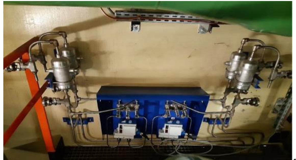
Nouveaux capteurs de pression SEC pour détection d'une situation H1 robuste au SND
