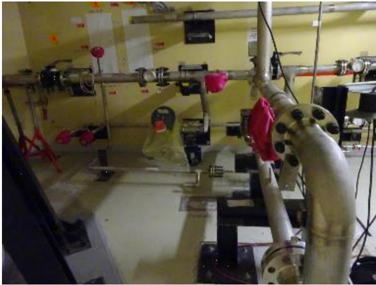
Montage panoplie sur le cadre d'air
