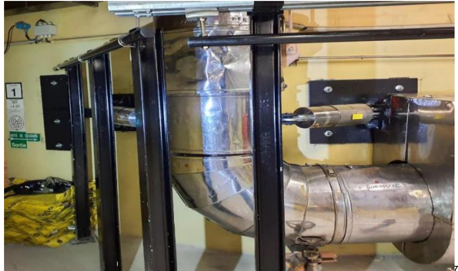
Ajout de supports sur le Circuit Secondaire Principal
