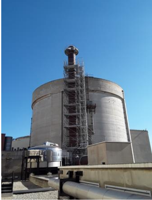
Echafaudage pour la réalisation des travaux - Hauteur de 40m
