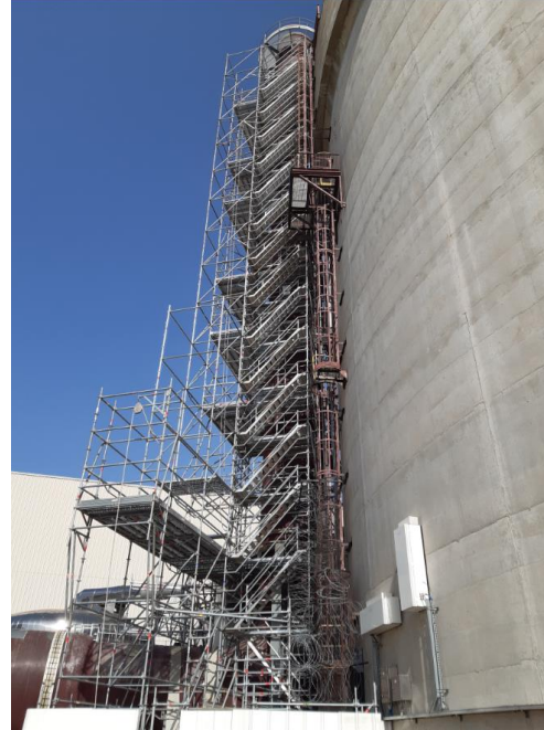
Echafaudage pour la réalisation des travaux - Hauteur de 40m
