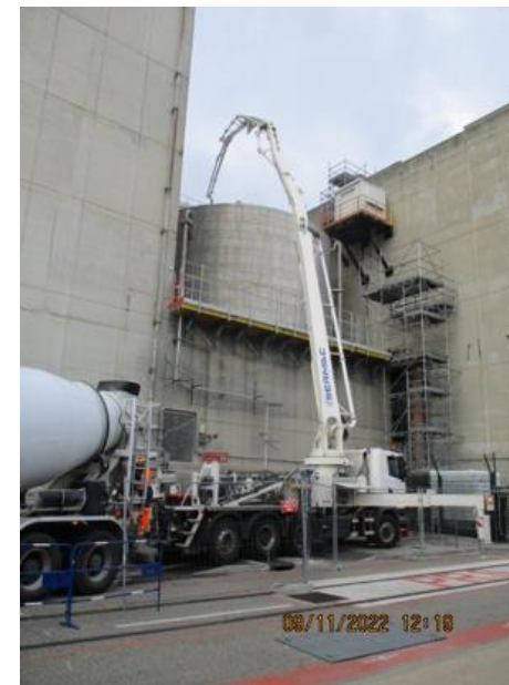
Coulage des fondations recevant la charpente
