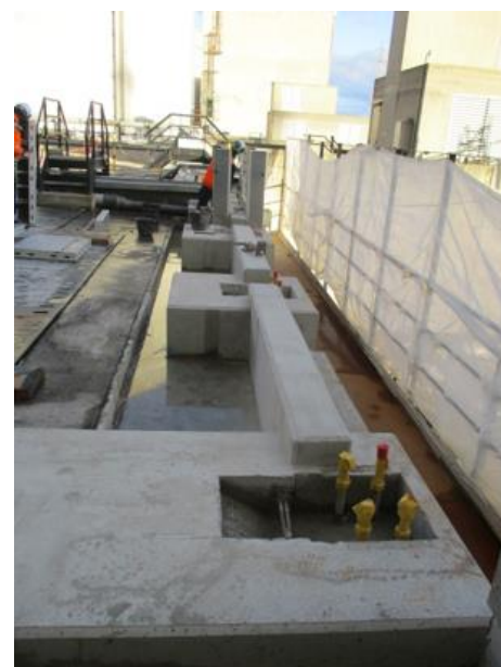
Coulage des fondations recevant la charpente
