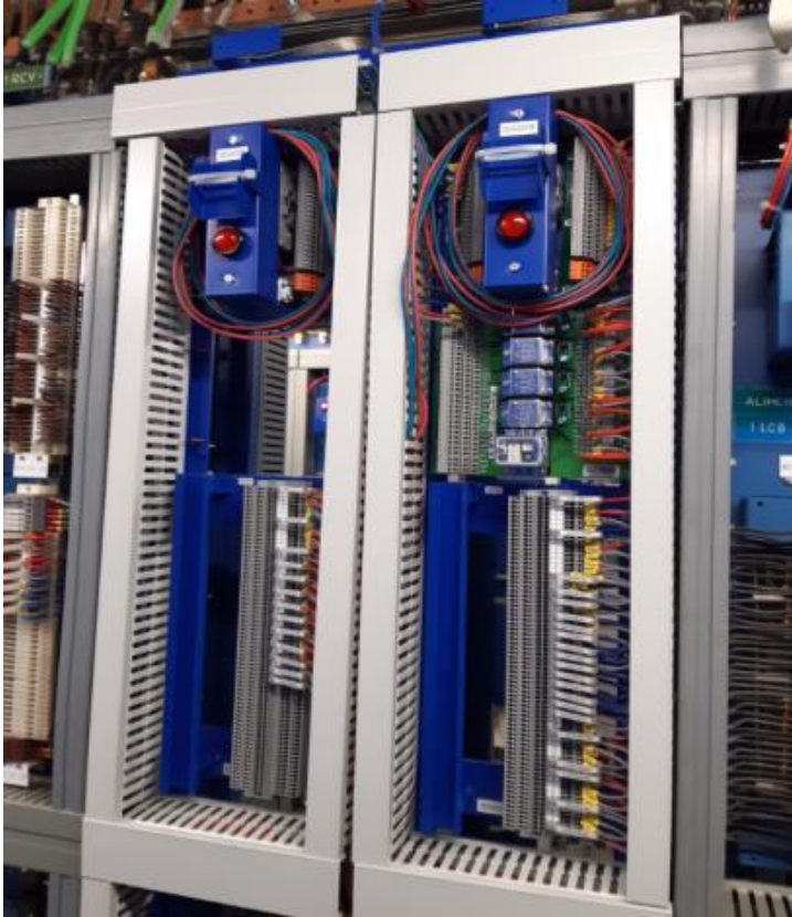
Pose du châssis de relayage
