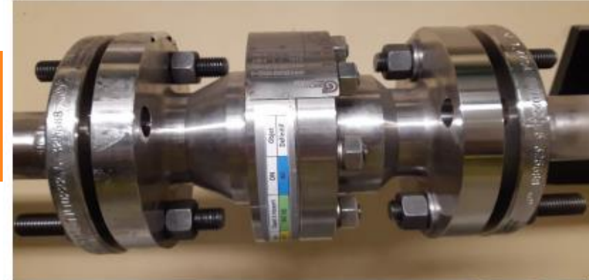
Installation clapet et débitmètre (poste de vannage SEG)
