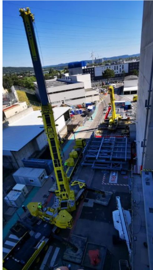
Implantation d'une grue 450 T
