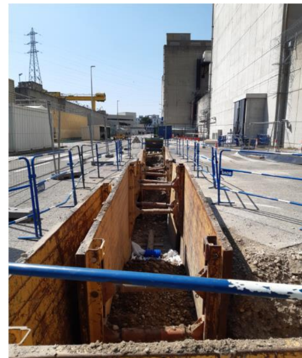
Tranchée pour tronçons 18 et 19
