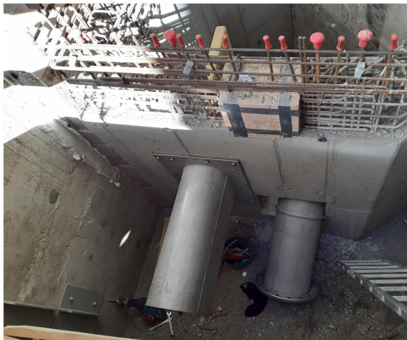
Chambre d'entrée dans le bâtiment
