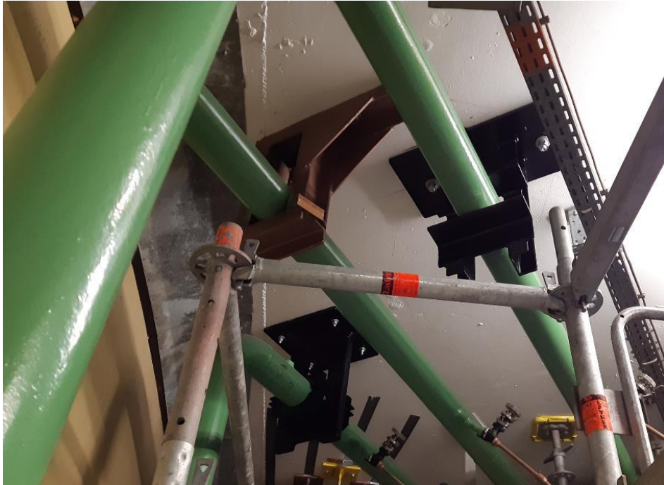
Pose de renforts sur les tuyauteries ASG
