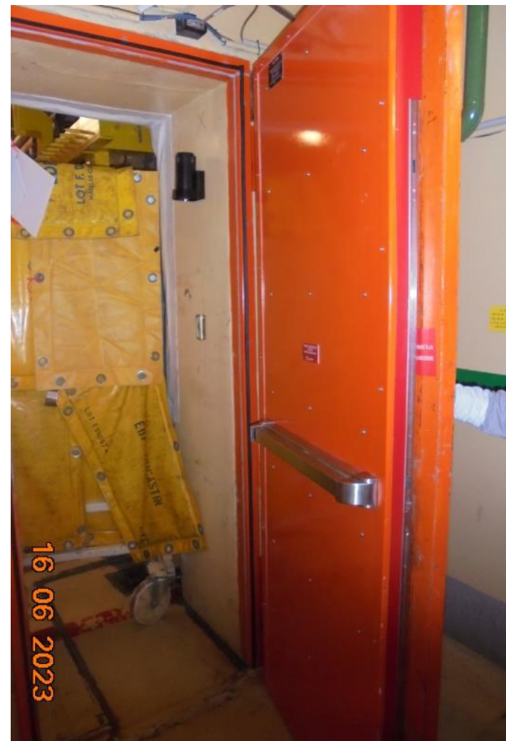
Mise en place du panneau coupe-feu (après)
