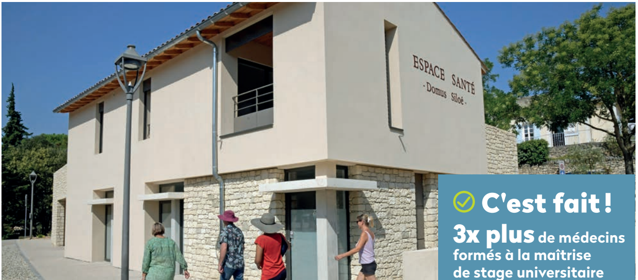
Maison de santé - Saint-Restitut
